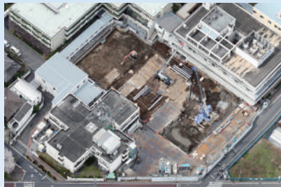
解体工事終了時 2023.3
